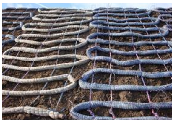
Rys. 1. Instalacja geotekstyliów na skarpie żwirowiska Nieboczowy
