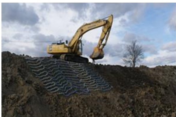
Rys. 1. Instalacja geotekstyliów na skarpie żwirowiska Nieboczowy
